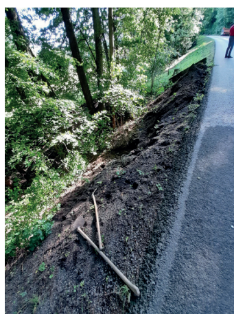
Bankettsanierung Bergstraße Rudersdorf
